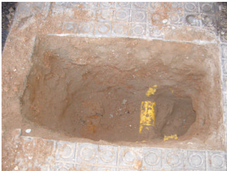
Presència de serveis dins la cala realitzada
