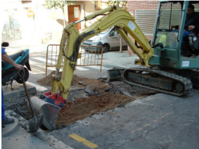
Treballs de rebaixos en l'encreuament del carrer d'Annibal
