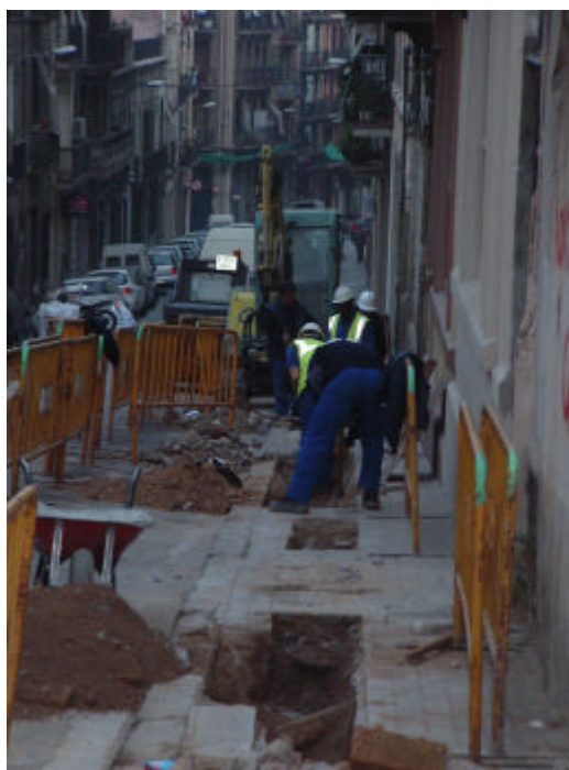
Treballs d'adequació de la rasa del carrer Tapioles
