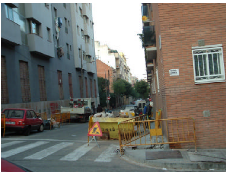
Treballs inicials cal carrer d'Annibal
