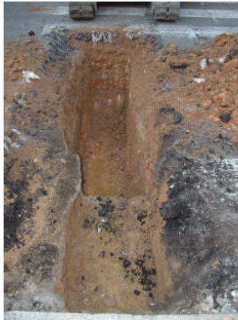
Tram obert en l'encreuament del carrer Tapioles
