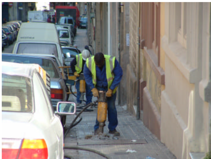
Treballs inicials al carrer Tapioles
