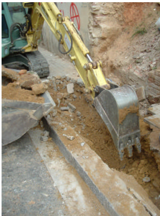
Presència de sauló al subsòl del carrer Tapioles
