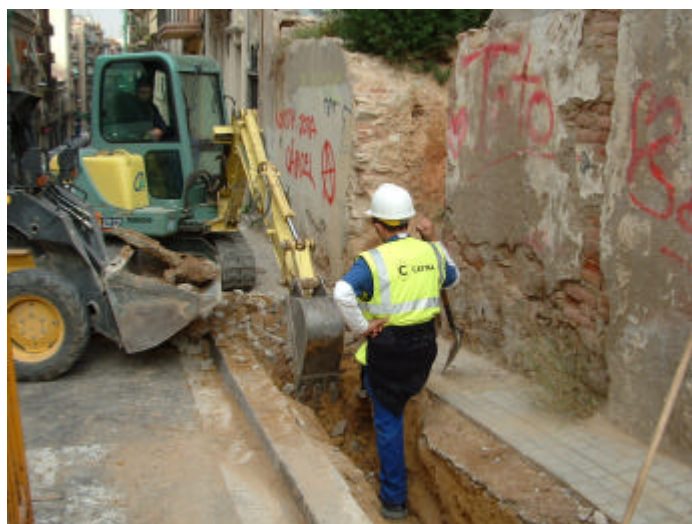
Treballs de rebaixos al carrer Tapioles
